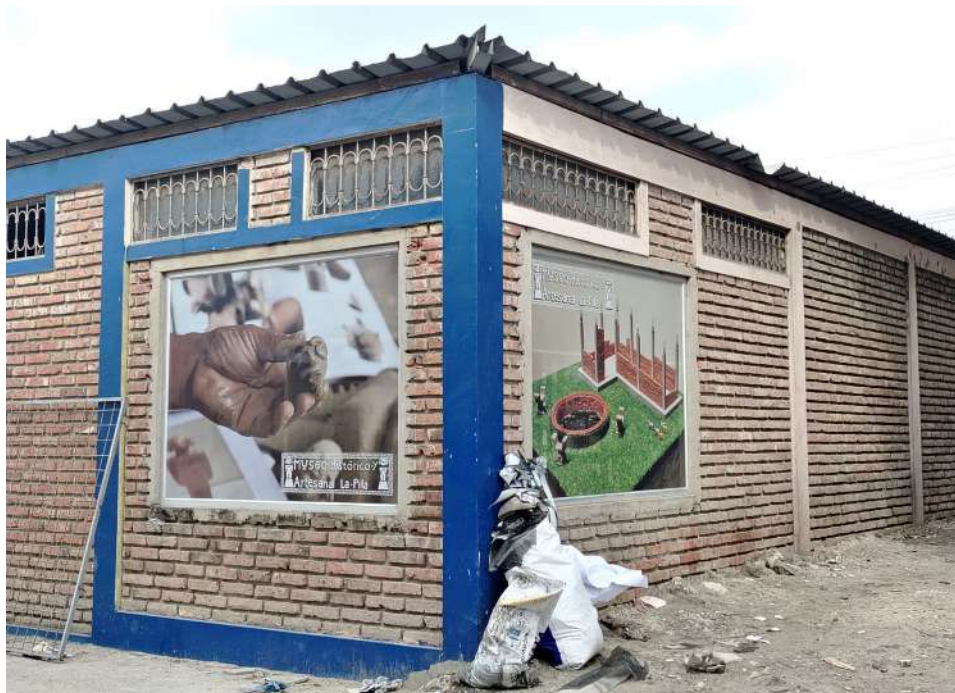
Imagen 10 Fachada del museo hacia la calle mientras se instalaban los adhesivos en las ventanas. Foto de Gema Quijije, 2024.
